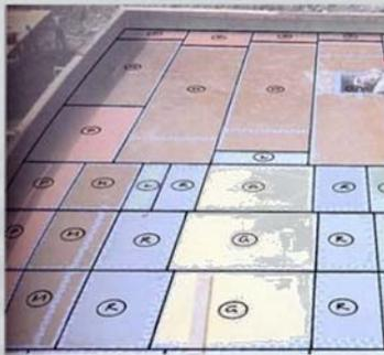
Sylomer® 是混合细胞结构，主要由聚醚(polyether)和聚脂 (polyester polyols) 等组成。这物料可应用于不同范围，如建筑、机械减震和工业等。它的弹性夹层如弹簧般，能顺应应用及建造的需要。
