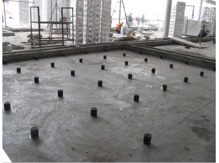
施工单位按深化设计图布点
