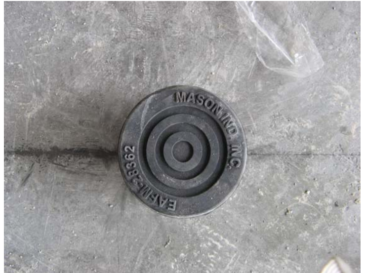
MASON 合成橡胶减震器 (型号: EAFM 100mm 高)
