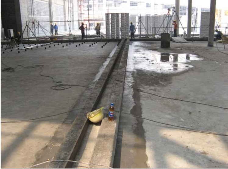
施工单位清理工地后，按深化设计图布点
