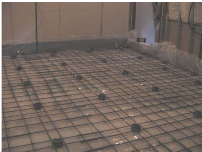
安装队伍根据我司设计 铺设 MASON 自升式减震器
