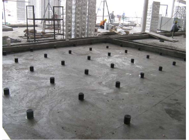
施工单位按深化设计图布点
